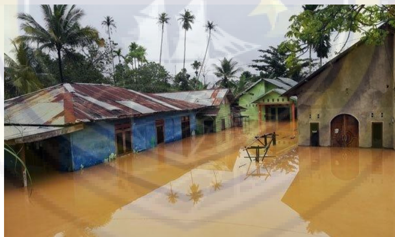
Kondisi Banjir di RT I yang mencapai ketinggian 1- 1,8 meter
