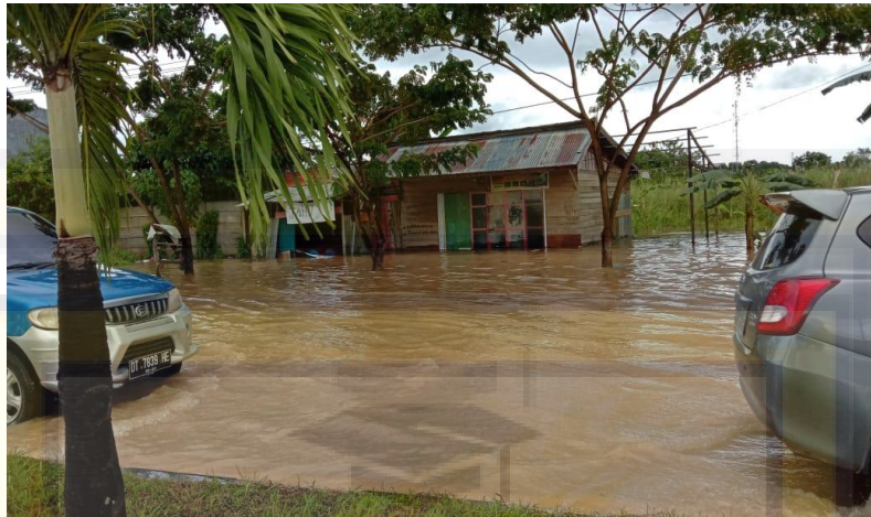
Kondisi Banjir di RT II yang mencapai ketiangan 40- 60 cm
