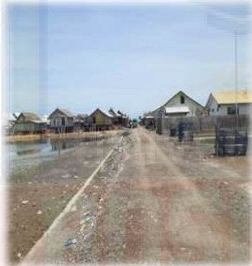
Gambar.4.11 Kondisi Jalan yang masi pengerasan
