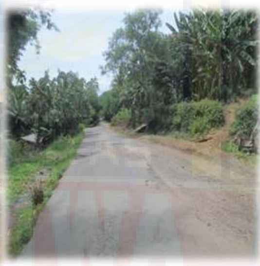
Gambar 4.12 Kondisi jalan yang sudah beraspal
