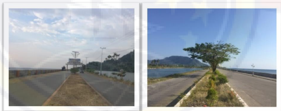
Sumber : Observasi lapangan 2018 Gmbar 4.8 Kondisi Jalan Bypass Tobaku-Lasusua
