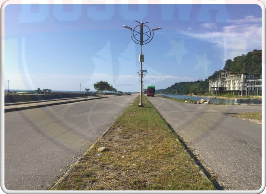
Kondisi Jalan Bypass Tobaku-Lasusua Tahun 2018
