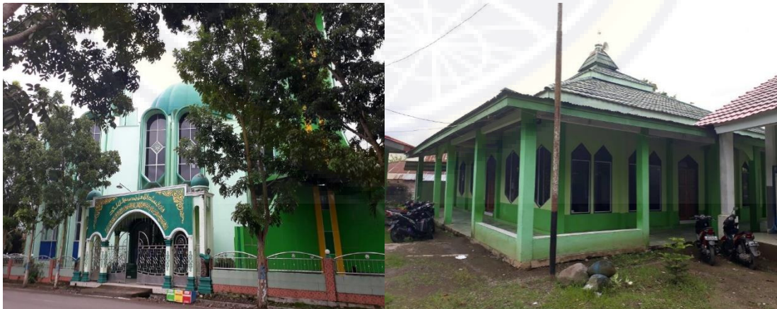
Gambar 4.3. Kondisi Fasilitas Peribadatan
