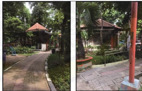
Gambar: 2.28 Fasilitas Mushollah dan Toilet Umum (Sumber: Dokumentasi Penulis 7 November 2018 Kota Surabaya)
