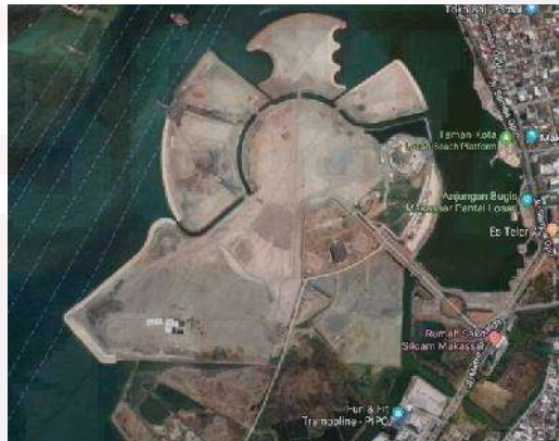
Proses pembangunan CPI Kota Makassar
