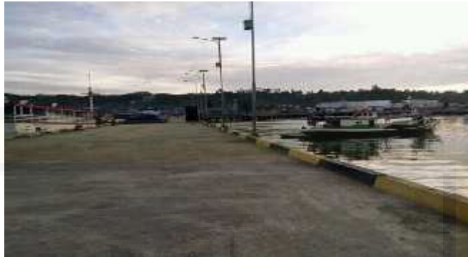
Gambar 4.6 Lampu penerangan pelabuhan
