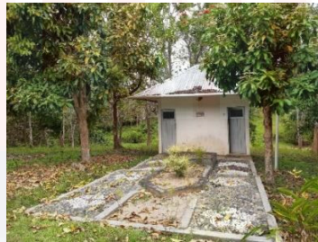
Gambar 4.16 Toilet (WC umum) di Kebun Raya Massenrempulu (Sumber Foto : Hasil Survey Tahun 2020).
