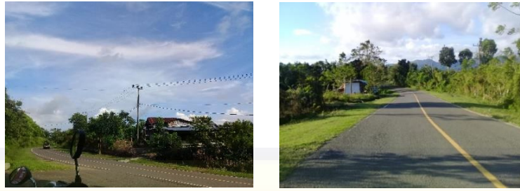
Gambar 4.20 Kondisi Jalan menuju Kebun Raya Massenrempulu (Sumber Foto : Hasil Survey Tahun 2020).
