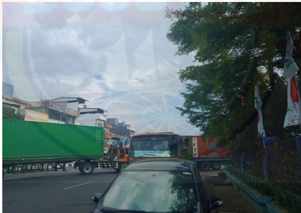
Gambar Lampiran 1.5. kondisi jalan di lokasi survey
