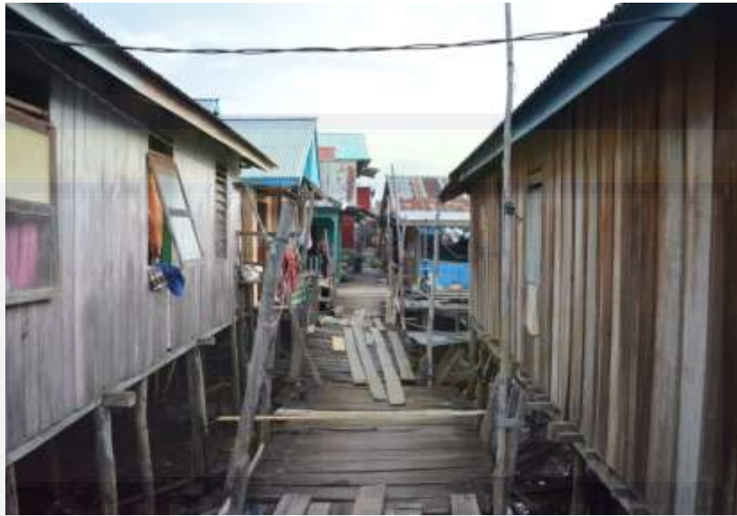
Gambar Kondisi Bangunan Kelurahan Sidoarjo
