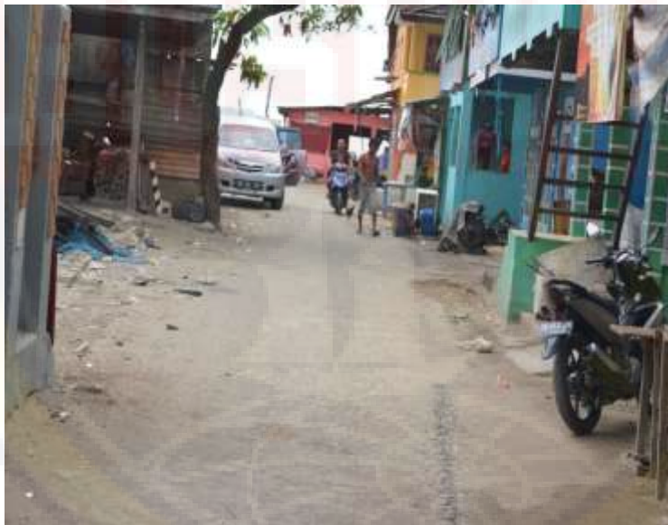
Gambar Kondisi jalan Di Luar Sepadan Pantai Kelurahan Sidoarjo
