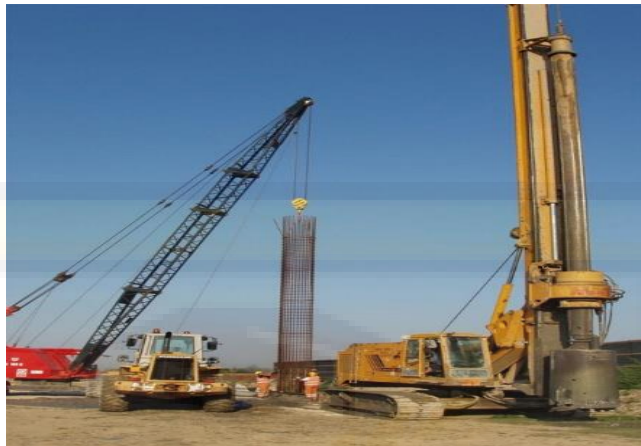
Gambar 3.3. Pekerjaan Pondasi Bore Pile
