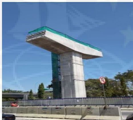
Gambar 3.6. Pekerjaan Pier Head
