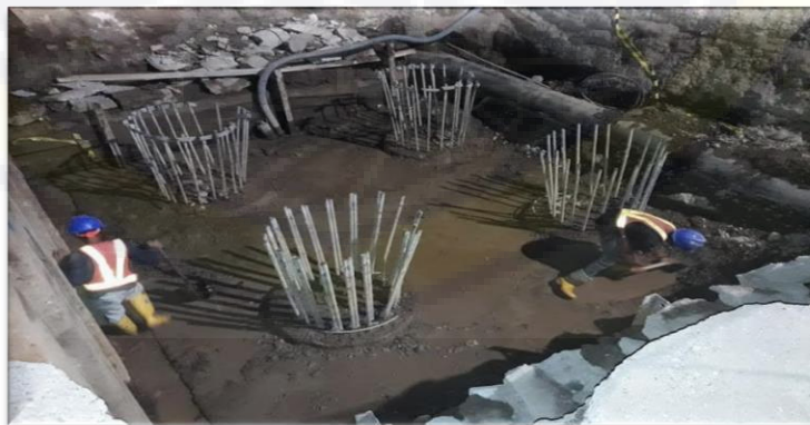
Gambar 3.4. Pekerjaan Pile Cap
