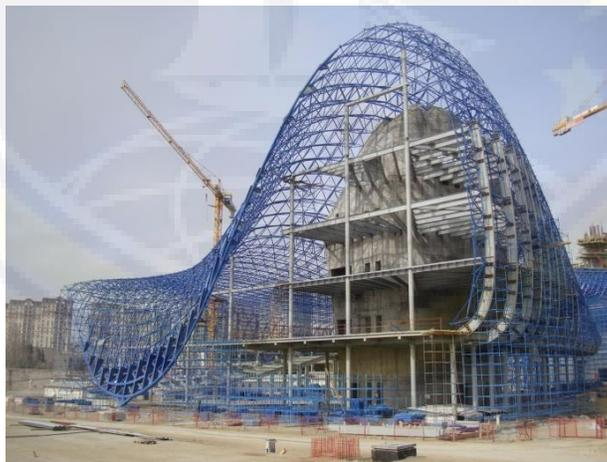
Gambar 6.10 Penerapan Rangka Ruang yang Mudah di bentuk
