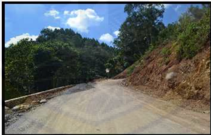
Kondisi Jaringan Jalan menuju Objek wisata
