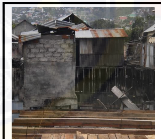
Kondisi MCK Yang terbuat dari batako dan beratap Seng Aluminium
