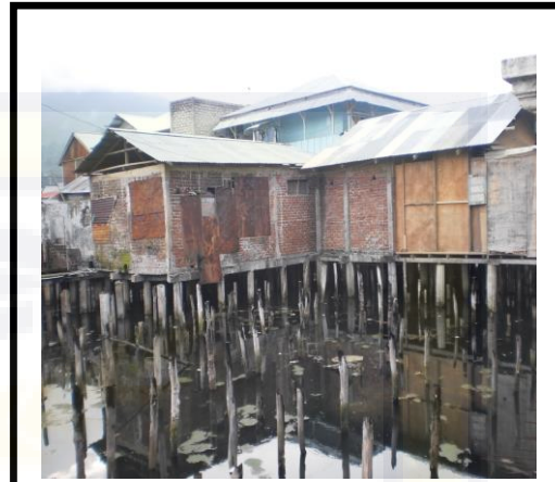
Kondisi Bangun Permanen Dengan Bahan Material dari Batako dan Papa Kayu dan Beratap Seng Aluminium
