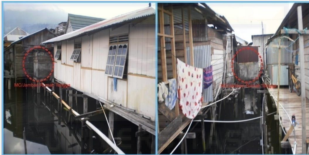
Gambar 4.13 Kondisi WC/Kakus Rumah Tangga di zona I Kelurahan Makassar Timur
