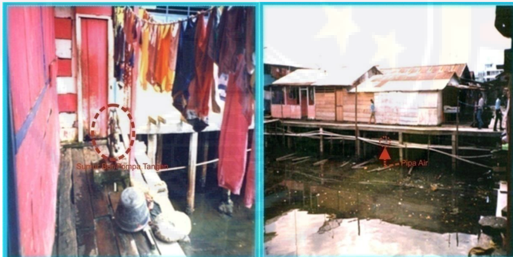
Gambar 4.12 Sumur Bor dan Pipa Air Di Setiap Rumah Pada Zona I Kelurahan Makassar Timur
