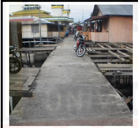
Kondisi Jalan lingkungan Yang Telah Beton
