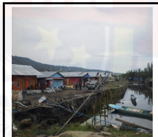
Kondisi Bangun Semi Parmanen Yang Terawat Sudah Dan Sudah Di Cat
