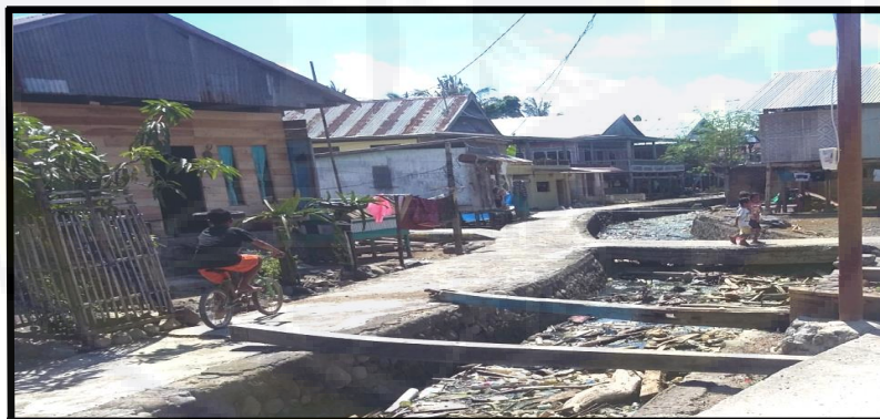
Gambar 4.4 Kondisi saluran yang tidak layak di Kawasan Lappa
