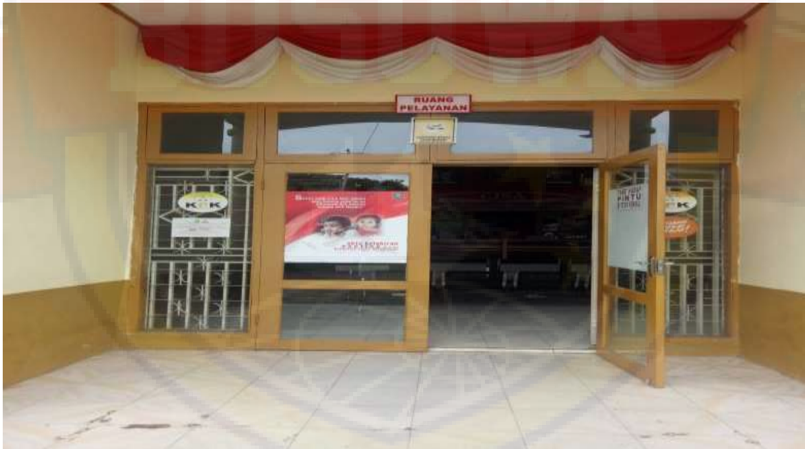
Pintu Masuk Ruang Pelayanan Dinas Kependudukan dan Pencatatan Sipil Sinjai
