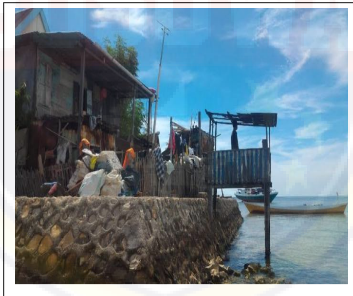
Jamban (MCK) di tepi pantai, di RT 06 Kelurahan Ampera
