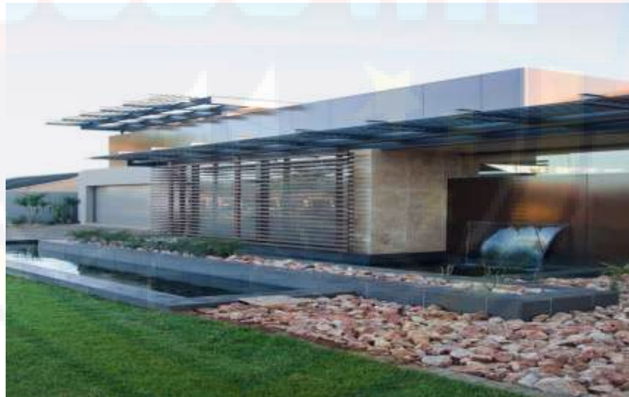
Gambar IV. 24 Penggunaan Sistem Shading Dan Overstek Pada Kaca (Sumber: Google Image, 2018)
