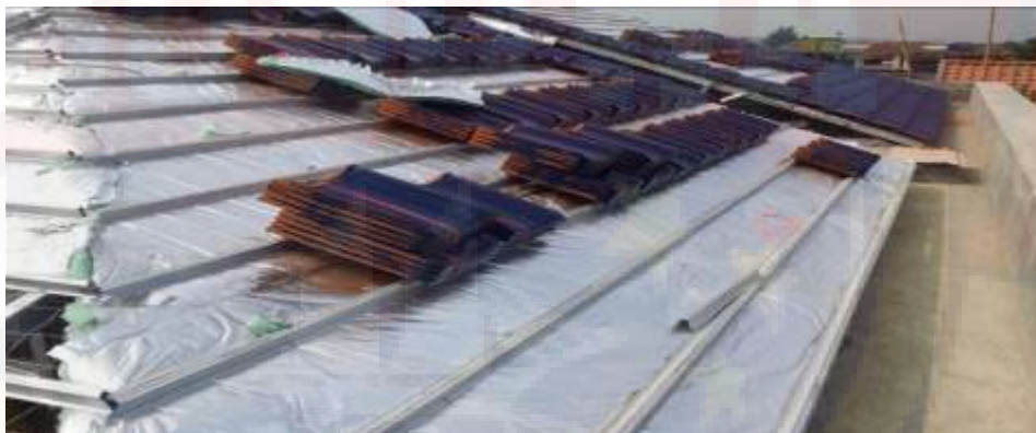
Gambar IV. 21 Pemasangan Aluminium Foil (Sumber: Analisa Penulis, 2018)
