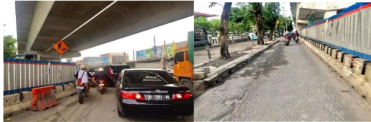
Gambar 6. Kondisi Penyempitan Ruas Jalan A.P.Pettarani. Sumber : Survei Lapangan, 2020
