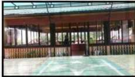
Gambar 2.57 : Aula Cottage Permata Indah Resort Sumber: Dokumentasi Pribadi, Februari 2022
