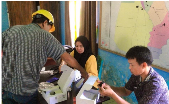
Gambar 2.6. Pemasangan penguat jaringan internet di kantor Desa Kaloling
