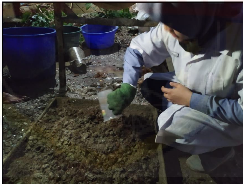
Gambar 4.40. menambahkan zat tambah ke dalam campuran beton
