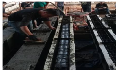
Gambar 6. Pengecoran benda uji
