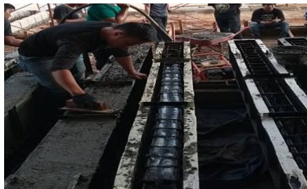
Gambar 6. Pengecoran benda uji
