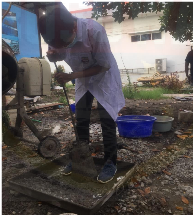
Gambar 10. Pengujian slump test
