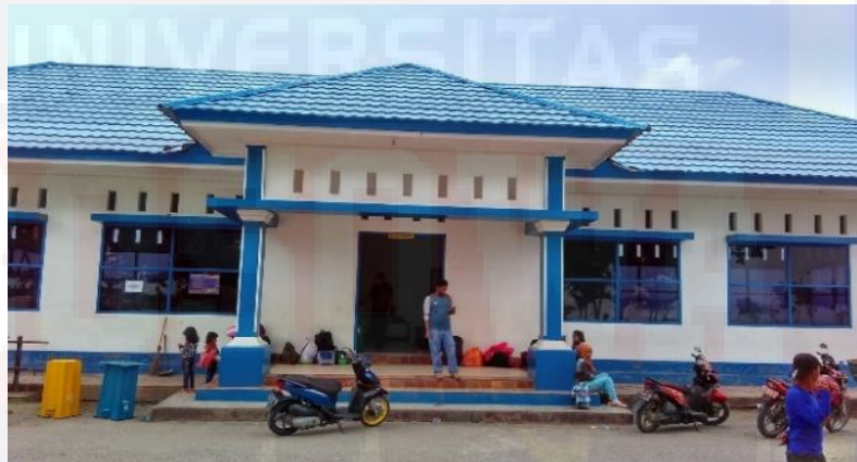
Gambar: 3. 11. Kondisi Gedung Terminal Pelabuhan Nusantara Raha (Sumber: Dokumentasi Penulis, 2017)
