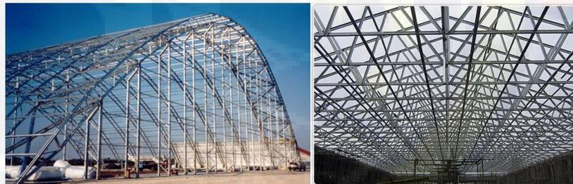
**Gambar 5.15** Struktur *space frame*
