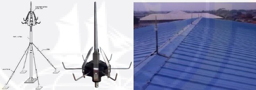
**Gambar 6.19** Sistem Penangkal Petir
