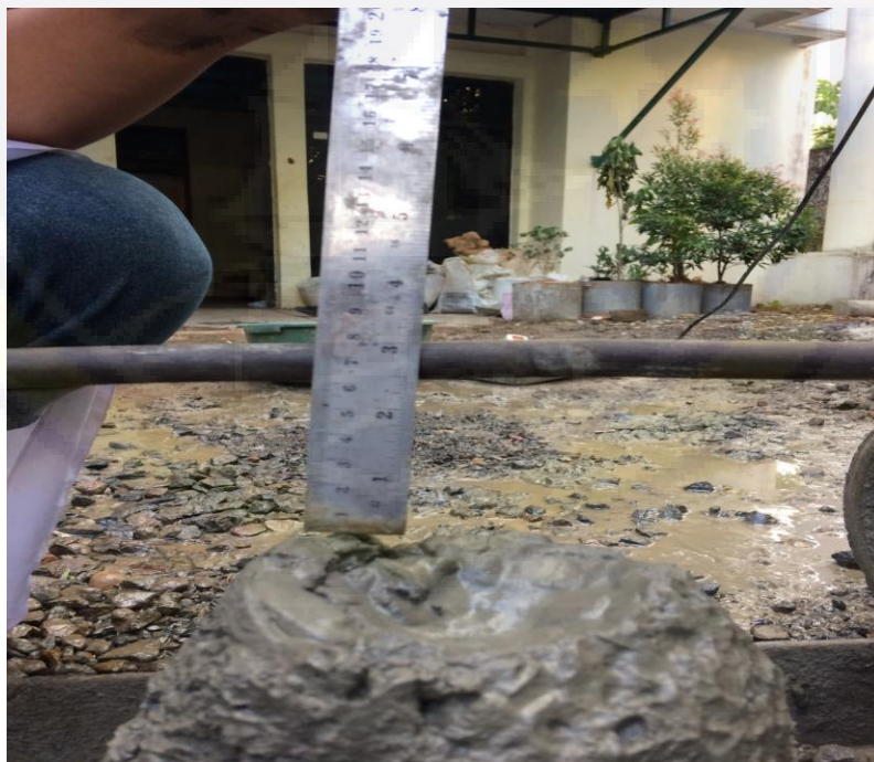
Gambar 6. Proses Pengujian Slump
