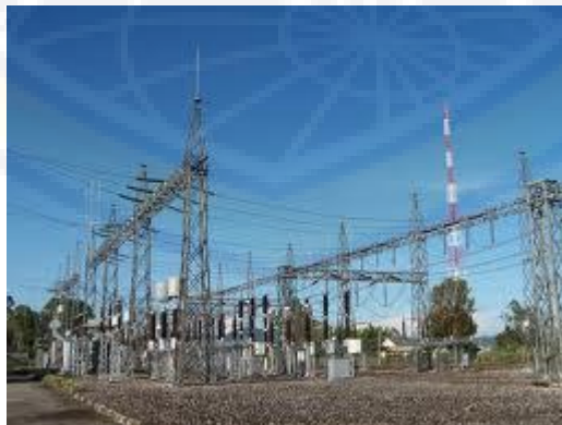
Gambar 2.2. Struktur Baja Post & Beam
