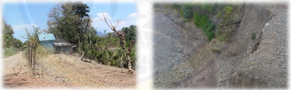
Gambar 4.22 Pembangunan Permukiman Di Pinggiran Sungai Yang Menyebabkan Longsor Pada Bibir Sungai Kawasan Perbatasan Negara Di Motaain
