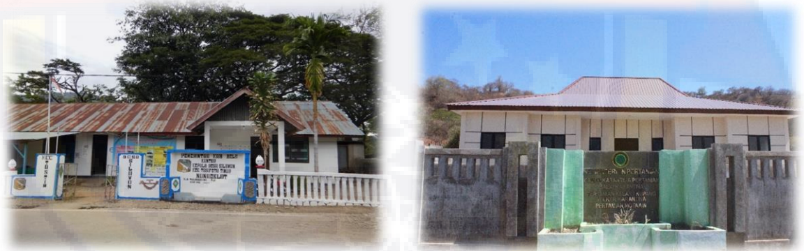
Gambar 4.19 Fasilitas Perkantoran Kawasan Perbatasan Negara Di Motaain
