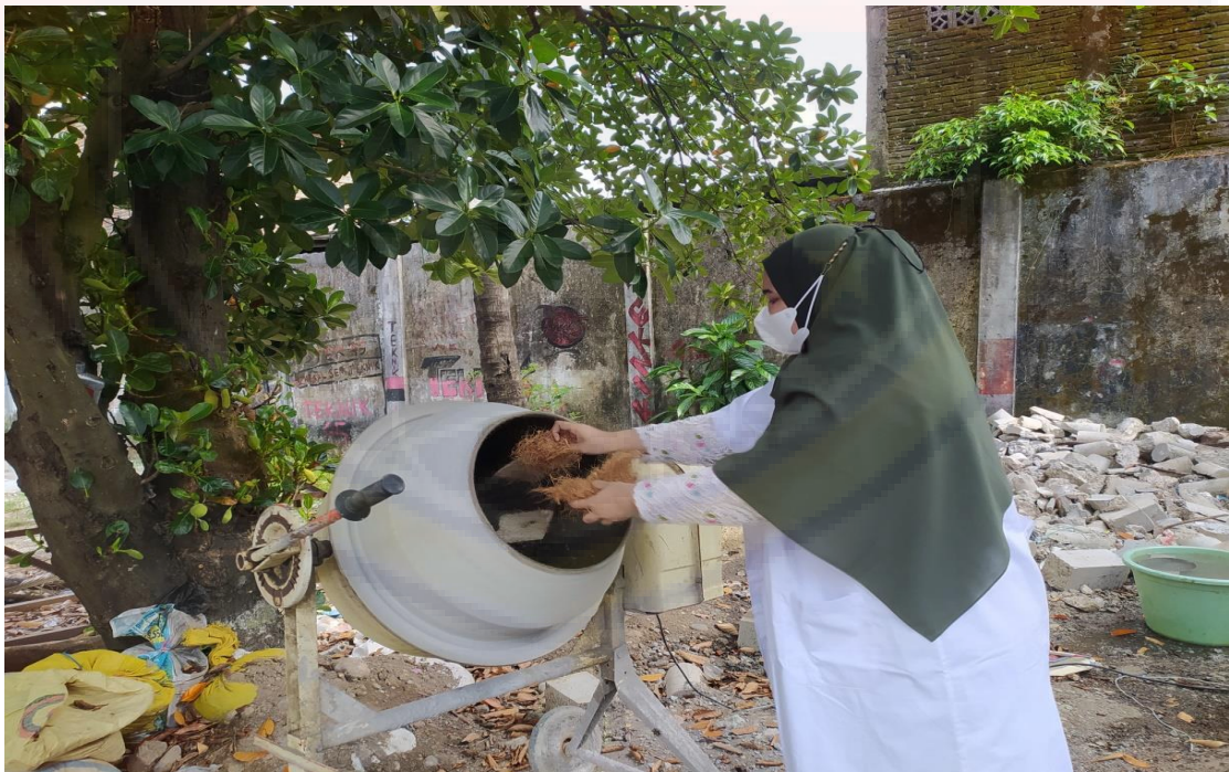
Gambar 12. Proses Penambahan Sabut Kelapa Pada Campuran Beton
