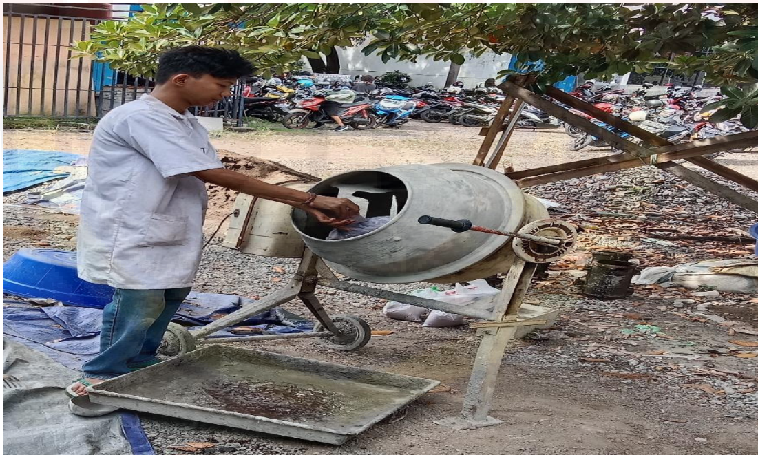
Proses Pencampuran Beton
