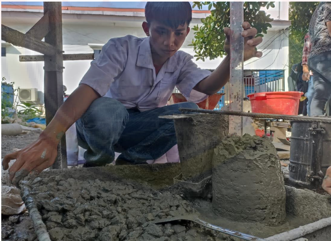
PENGUJIAN SLUMP TEST
