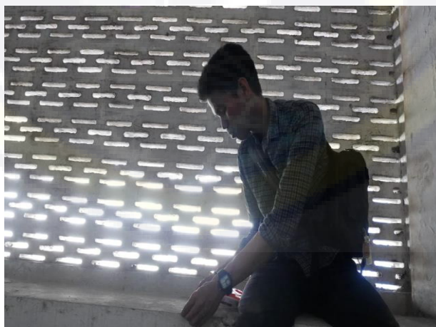
Foto : Pengukuran Lebar Balok Gedung Kampus I Universitas Bosowa
