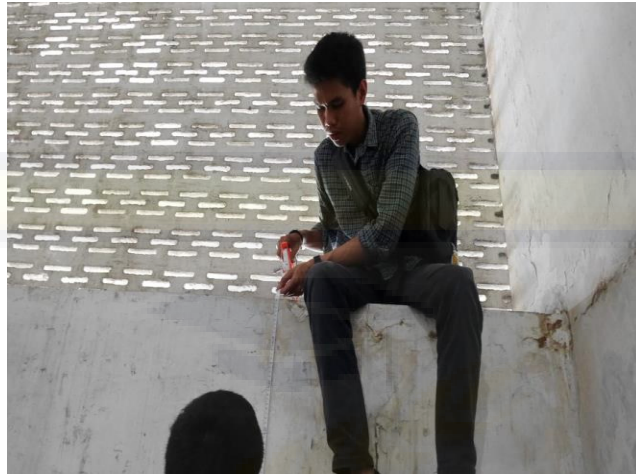
Foto : Pengukuran Tinggi Balok Gedung Kampus I Universitas Bosowa
