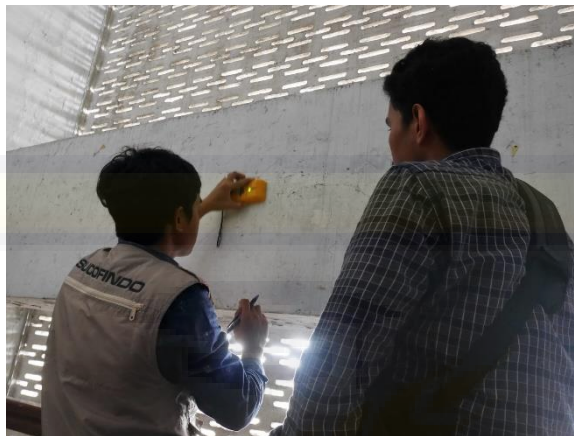
Foto : Pengujian Rebar Scanner Titik Balok Beton Gedung Kampus I Universitas Bosowa
