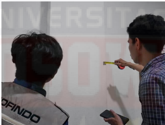
Foto : Pengukuran Jarak Tulangan Titik Balok Beton Gedung Kampus I Universitas Bosowa
