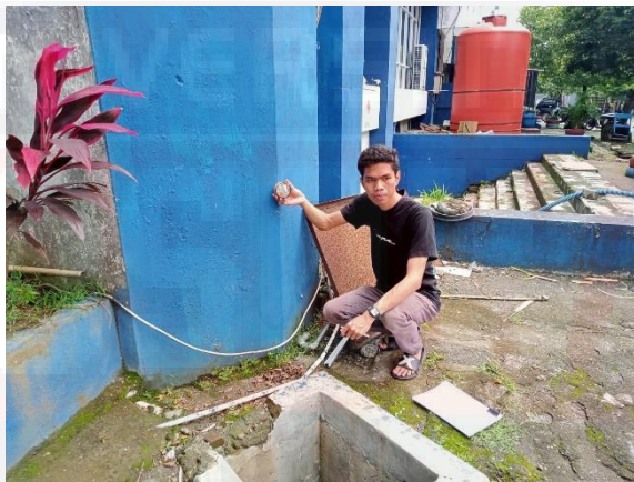
Foto : Pemasangan Titik (Bawah) Gedung Kampus I Universitas Bosowa
