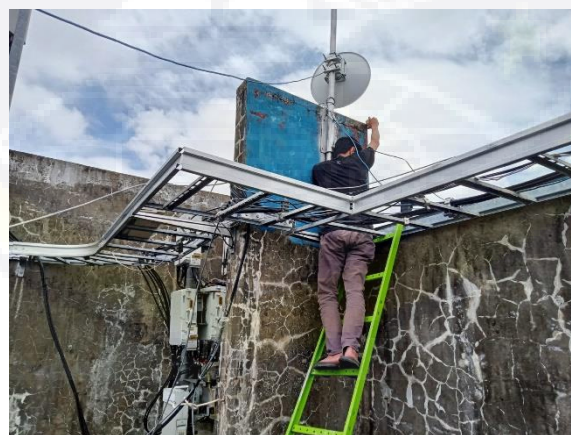
Foto : Pemasangan Titik (Atas) Gedung Kampus I Universitas Bosowa
