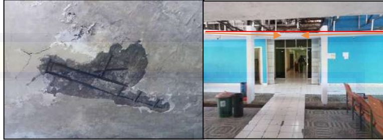
Gambar 1.2 : Pembesian plat lantai yang terekspos dan struktur balok yang membengkok
