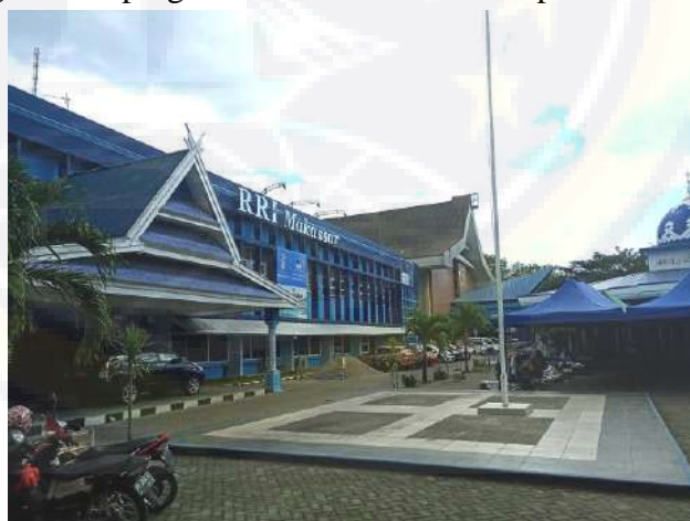
Gambar 3.3: Kantor RRI Makassar Sumber: Dokumentasi penulis, 2018
