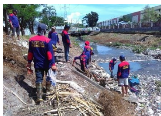
(a) Situasi perbaikan kanal
