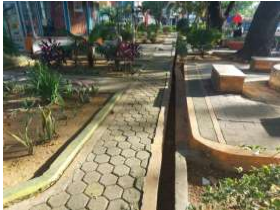
Gambaran 4.2 Kondisi jalan di Lokasi Ruang Terbuka Hijau Kondisi Air Bersih
