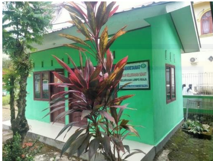
Observasi awal (Kondisi Bangunan Kantor Kelurahan Lompo Riaja)
