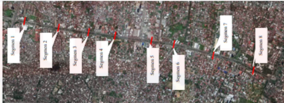
Gambar. 4.2. Ruas jalan terdampak langsung segmen AP.Pettarani Sumber : PT. PT.Bosowa Marga Nusantara, 2018
