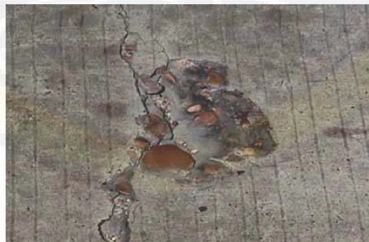
Gambar 2.15 Rocking pada perkerasan beton
