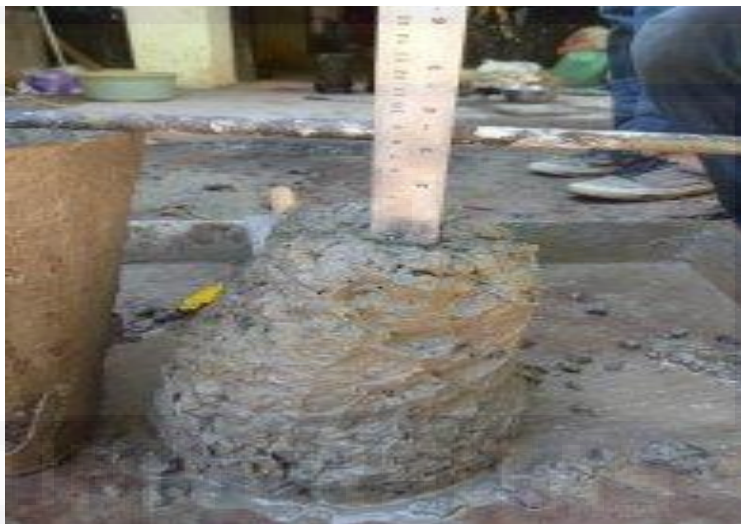
Gambar pengujian slump beton
