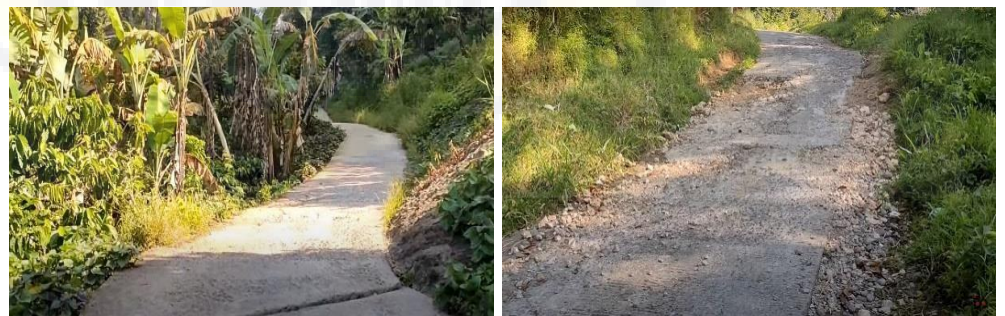
Gambar 4.21 Kondisi Jaringan Jalan Desa Marante
