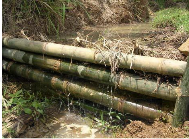
Gambar 2.8 Bangunan terjun air dari bambu
