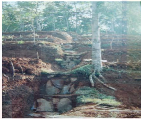
Gambar 2.7 Saluran Pembuangan Air
