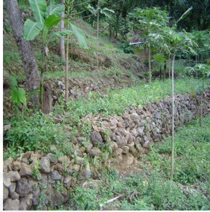
Gambar 4.12 Trap-Trap Terasering dari batu
