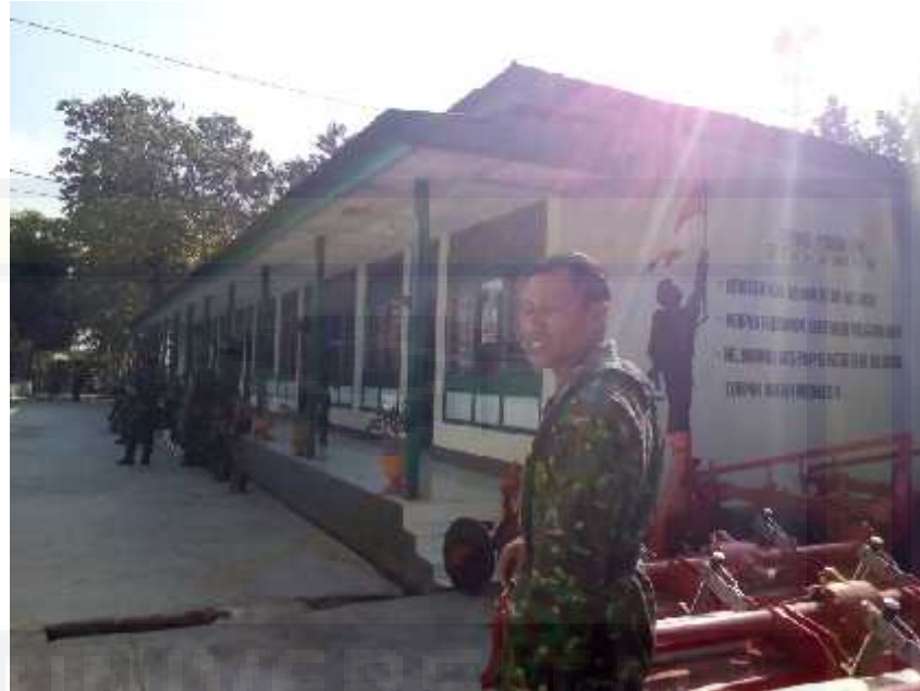
Gambar 3.14 Gedung Eselon Pemb. Pimpinan 1420 Sidrap (Sumber : Hasil Survey 2016)
