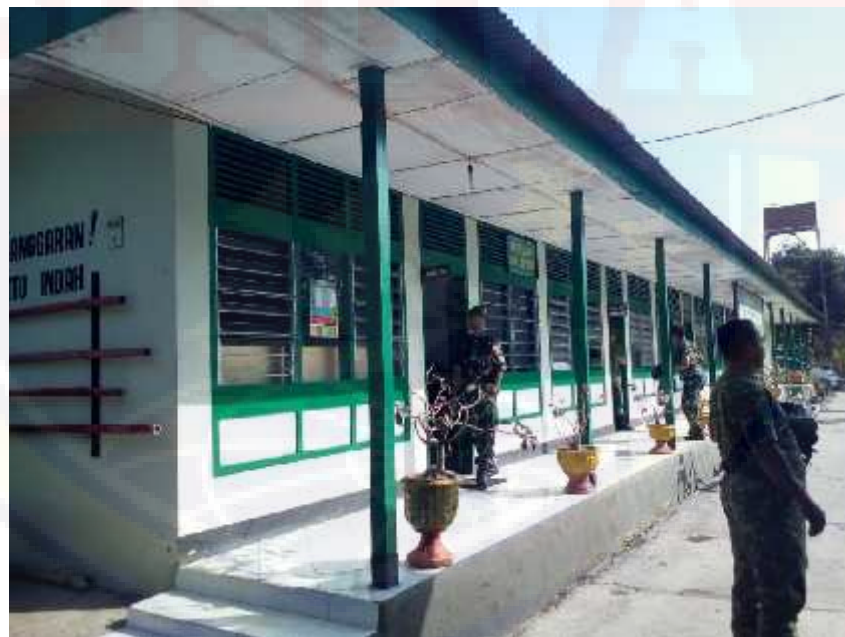
Gambar 3.15 Gedung Eselon Pemb. Pimpinan 1420 Sidrap (Sumber : Hasil Survey 2016)
