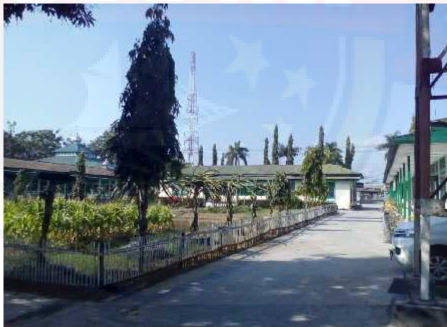
Gambar 3.9 Perwujudan Bentuk Bangunan 1420 Sidrap (Sumber : Hasil Survey 2016)
