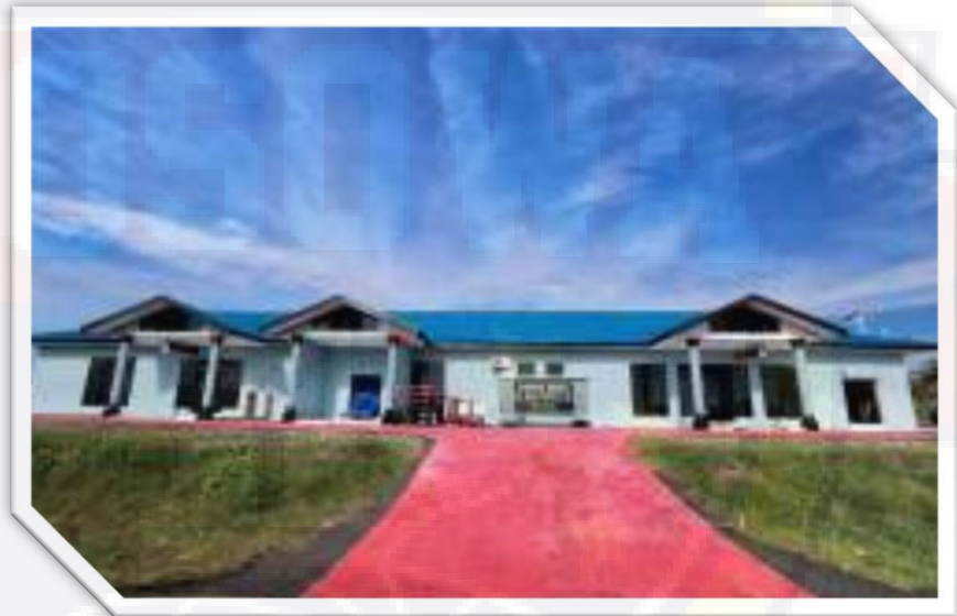
Gambar III.24 Eksisting terminal Bandara H.Aroepala Kabupaten Kepulauan Selayar
