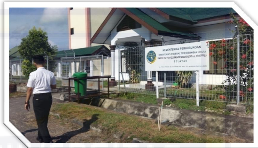
Gambar III.27 Kantor Bandara H. Aroepala Kabupaten Kepulauan Selayar
