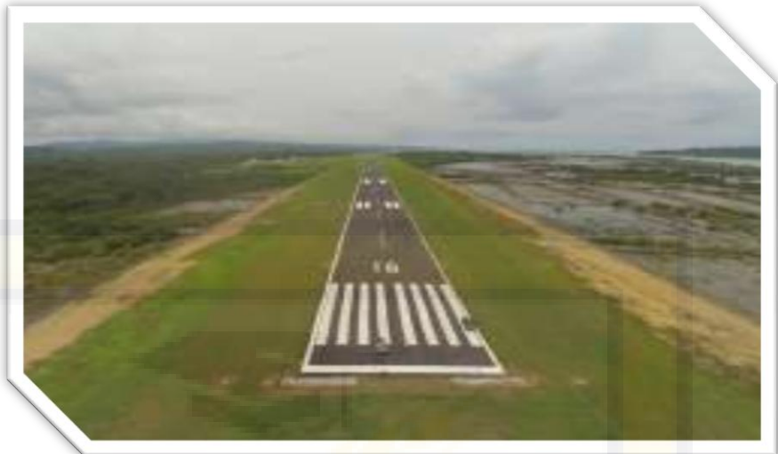
Gambar III.20 Eksisting landasan pacu( Runway ) Bandara H. Aroepala ( Sumber : Bandar Udara H. Aroepala Kabupaten Selayar 2016 )
