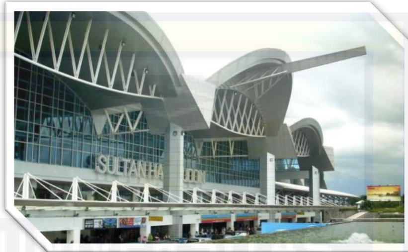
Gambar III.7 Eksterior Bandara Sultan Hasanuddin (Sumber : Bandar Udara Internasional Sultan Hasanuddin Makassar)
