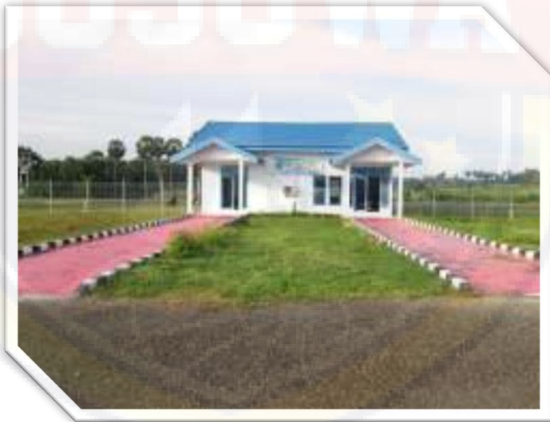
Gambar III.16 Terminal Bandara Arung Palakka (Sumber : Bandar Udara Arung Palakka Kabupaten Bone 2016)
