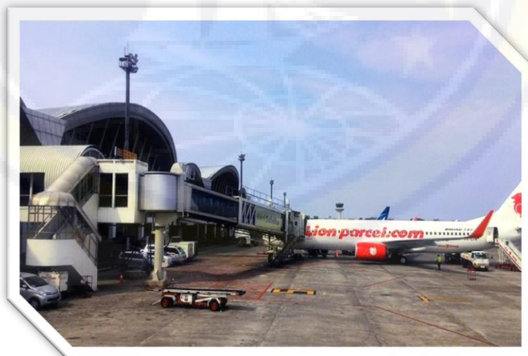
Gambar III.11 Fasilitas Apron Bandara Sultan Hasanuddin (Sumber : Bandar Udara Internasional Sultan Hasanuddin Makassar)
