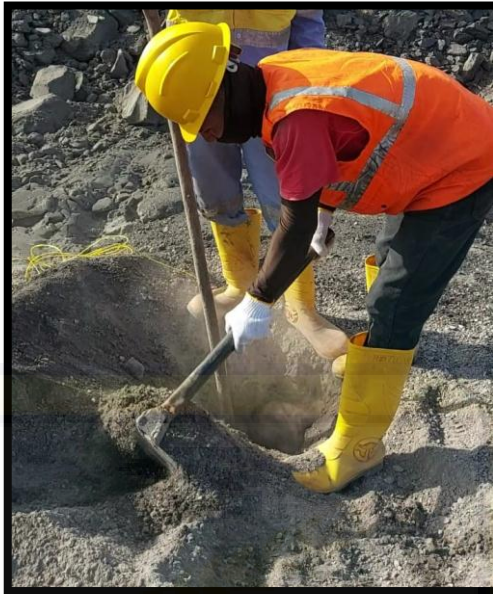
Gambar lampiran K. 4 Proses Stemming
