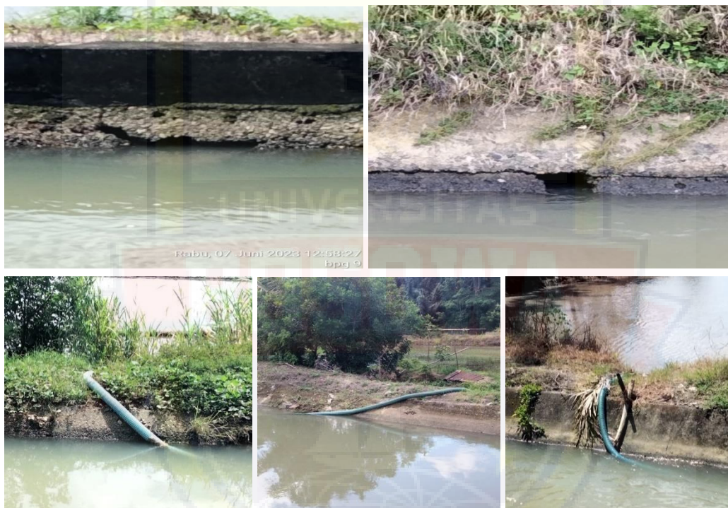
Gambar 4.27 Penyebab terjadinya kehilangan air
