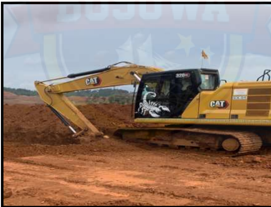
Gambar 7. Excavator yang digunakan dalam penatagunaan lahan.
