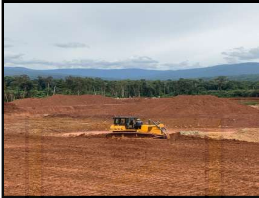
Gambar 8. Pengoperasian Bulldozer di lapangan
