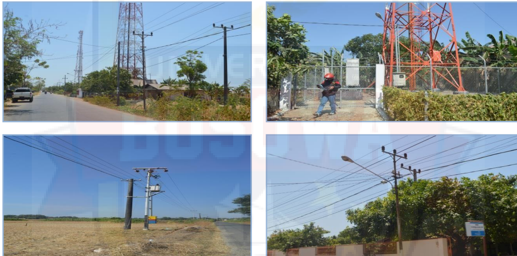
Gambar 4.11 : Kondisi Prasarana Jaringan Listrik
