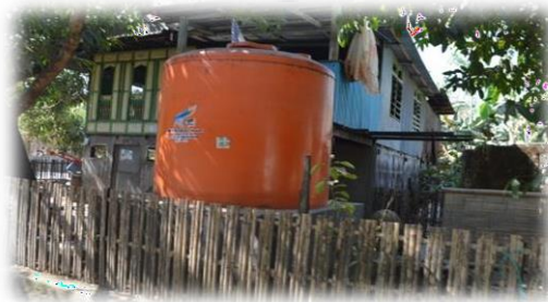
Gambar 4.10 : Kondisi wadah air bersih
