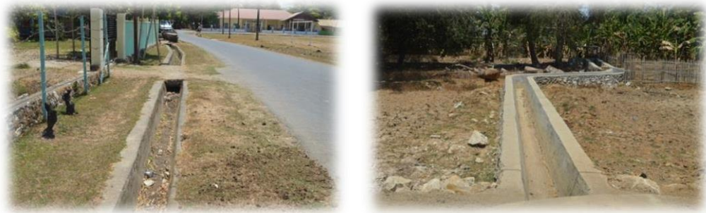
Gambar 4.9 : Kondisi Prasarana Drainase
