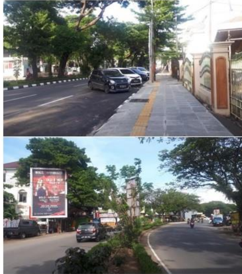
Gambar 4.1 Kondisi Hambatan Samping Jl. Letjend. Hertasing
