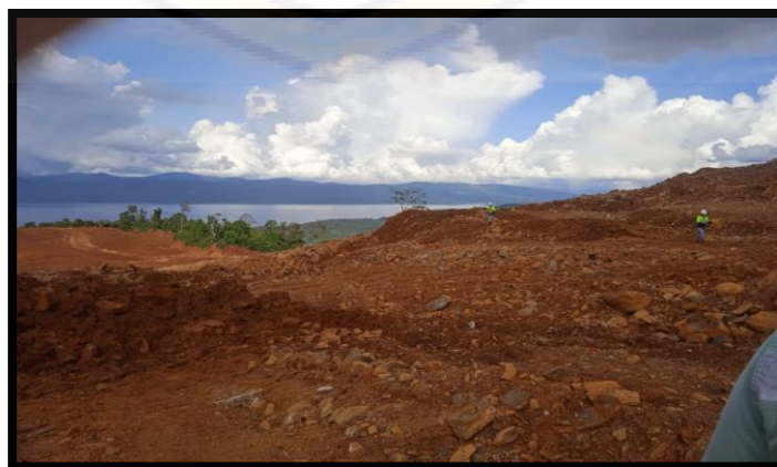
Gambar 4. 4 Penentuan Lokasi yang akan di bor Sumber : (PT.Vale Indonesia Tbk)
