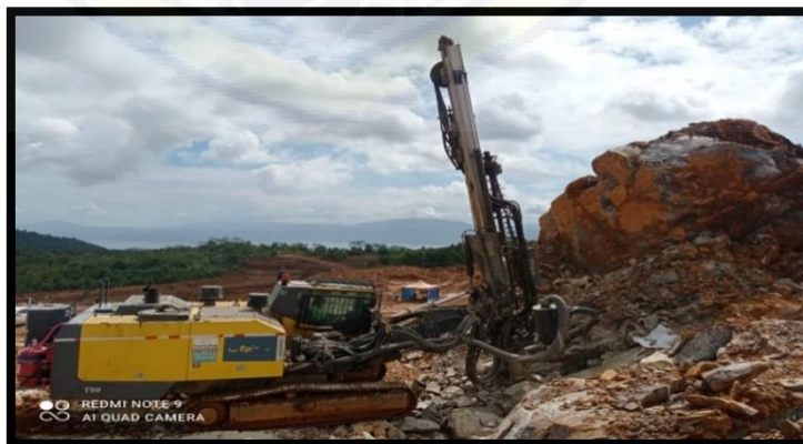
Gambar 4. 8 Pemboran Lubang Ledak Sumber : (PT.Vale Indonesia Tbk)
