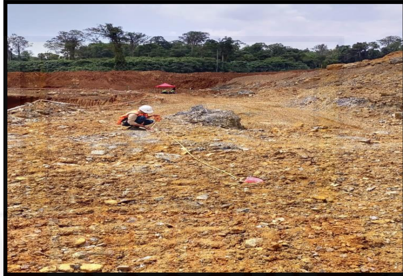
Gambar 1. Pengukuran Burden dilapangan menggunakan alat ukur meter
